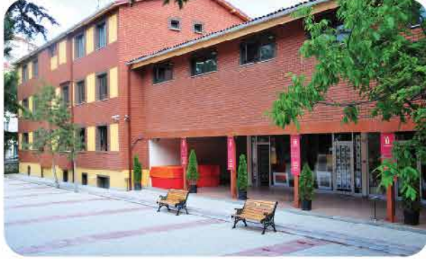
TEPEBAŞI BELEDİYESİ ÖZDİLEK SANAT MERKEZİ Hoşnudiye Mh. Tunç Sk. No:9
